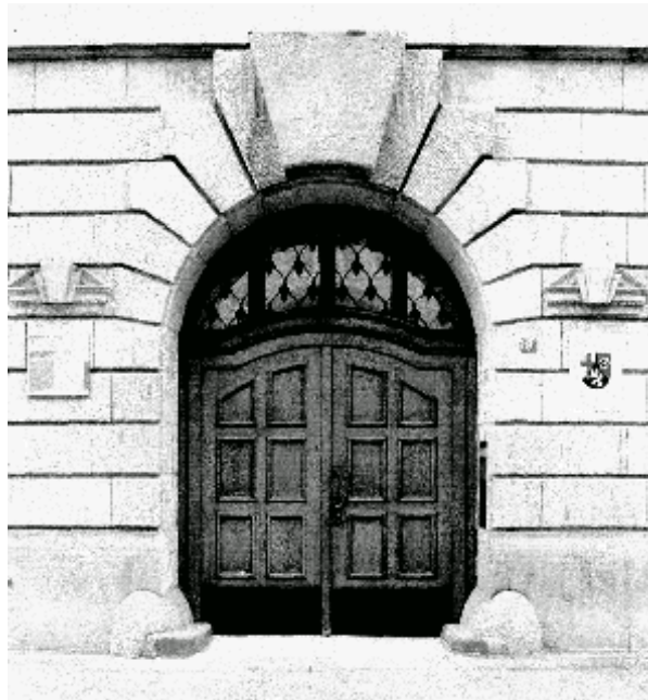
Eingangsportal des Verwaltungsgerichts in Mainz, Ernst-Ludwig-Straße 9
